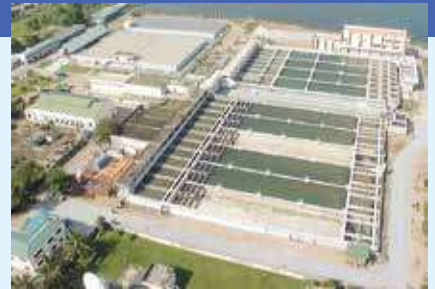
WTP Phum Prek adalah pengolahan air terbesar PPWSA dengan kapasitas 150.000 meter kubik per hari. WTP ini dibangun tahun 1966 dan sempat direhab tahun 1995.
