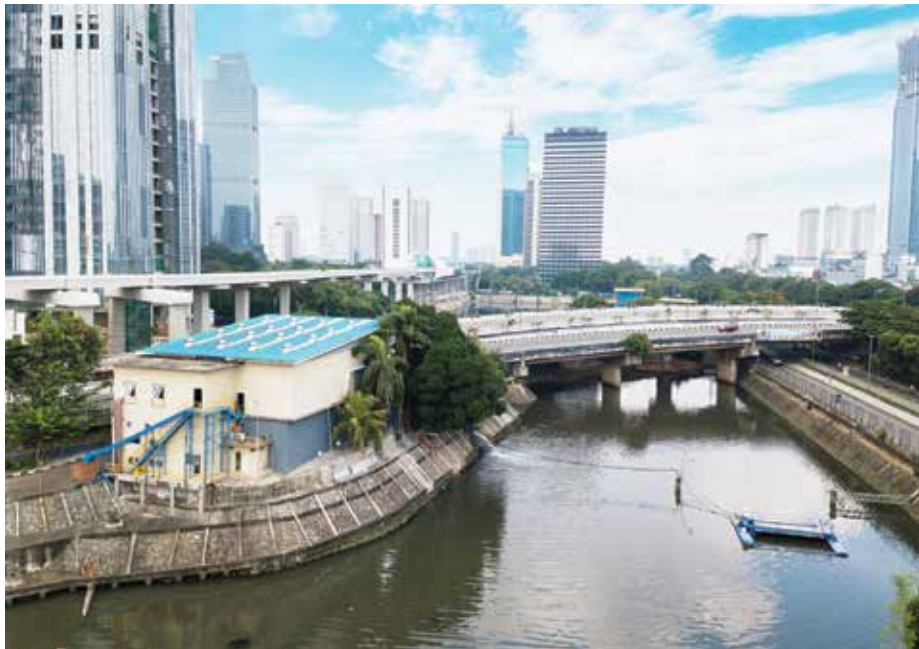
IPAL MBBR Setiabudi Jakarta kapasitas 250 liter per detik. Sistem pengolahan Moving Bed Biofilm Reactor (MBBR) merupakan pengolahan biologis kombinasi dengan memanfaatkan dua bentuk biomassa, yaitu flok tersuspensi dan terlekat (biofilm).
