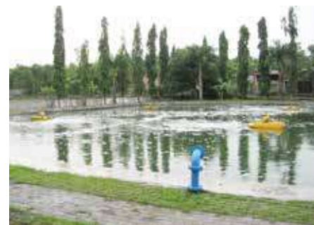
IPAL Mojongsongo Surakarta kapasitas 50 liter per detik. Sistem pengolahan Aerated Facultative Lagoon, yakni sistem pengolahan air yang menggunakan kolam atau waduk serta aerator. Aerator berfungsi memasok oksigen di dalam waduk. Pasokan oksigen berguna untuk mengolah air.
