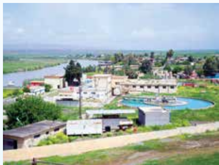
Salah satu instalasi pengolahan air minum Iraq. Butuh banyak pembenahan dan upgrade sistem.
